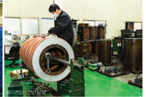
몰드변압기 건설 공정
